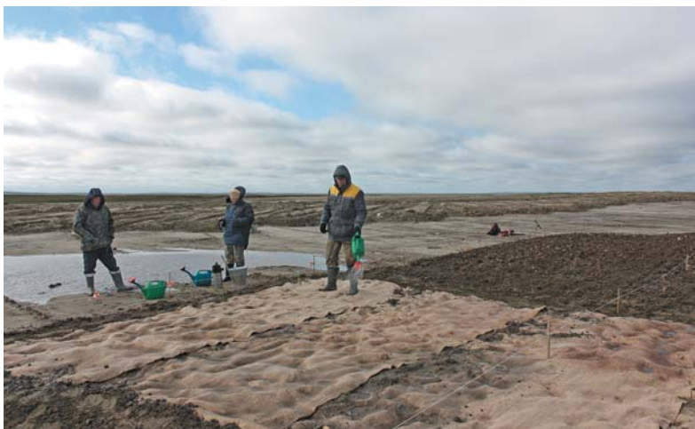
Рис. 2. Закладка экспериментальных участков рекультивации на карьере минерального грунта № 4 Бованенковского НГКМ с использованием биоматов марки БТ-СО/130 (2,0) в 2010 г.
